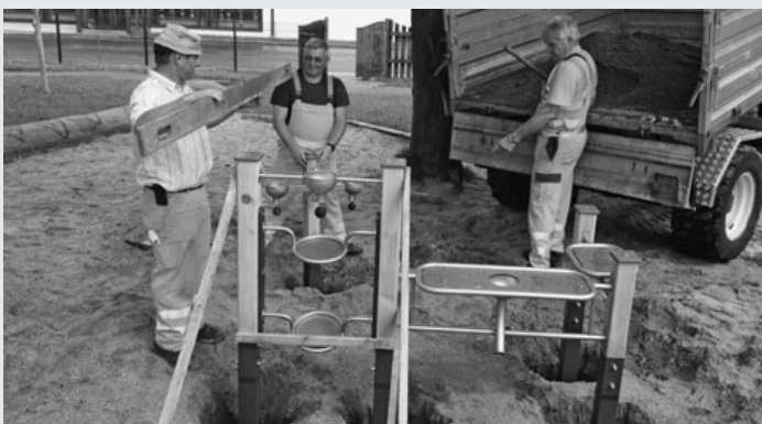
Unsere 3 „Sepps“ vom Bauhof geben sich hier ganz viel Mühe beim Einbau unseres tollen Spielgerätes im Sandkastenbereich. Dank des spendablen Fördervereins konnten diese teuren Spielgeräte für die Kinder angeschafft werden.
