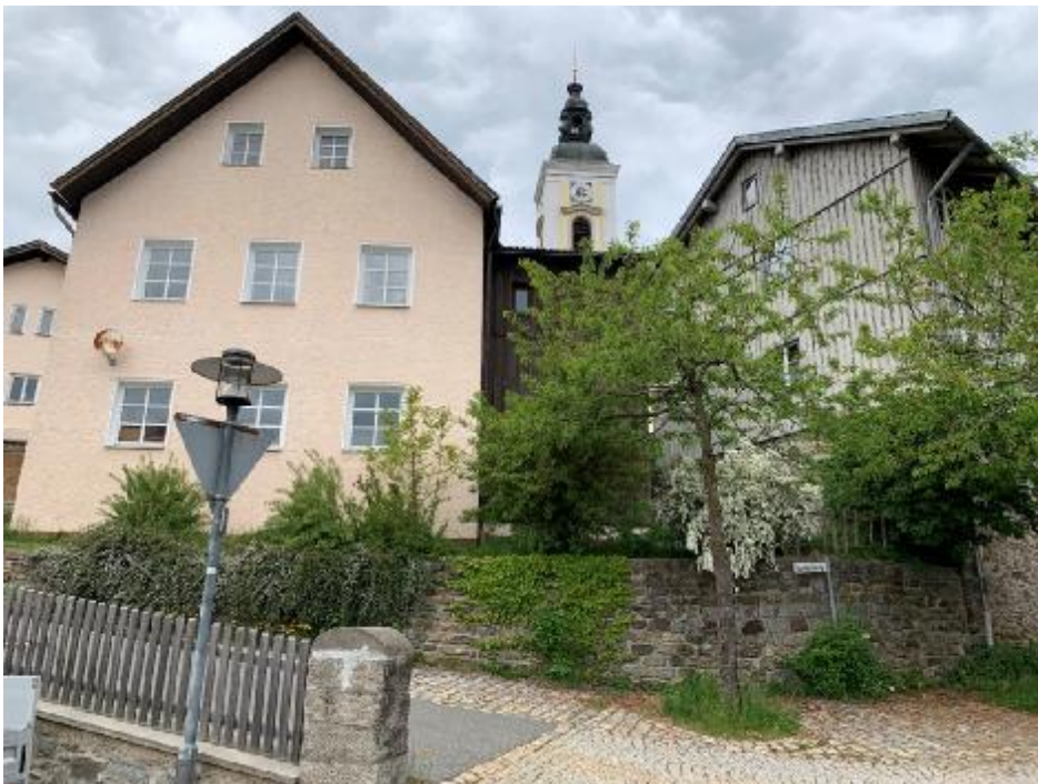
Abbildung 8: Bestandsgebäude südlich des Planungsgebietes, Foto Jocham+Kellhuber
