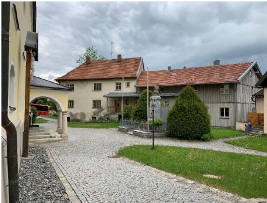
Abbildung 6: Bestandsgebäude östlich des Planungsgebietes, Foto Jocham+Kellhuber
