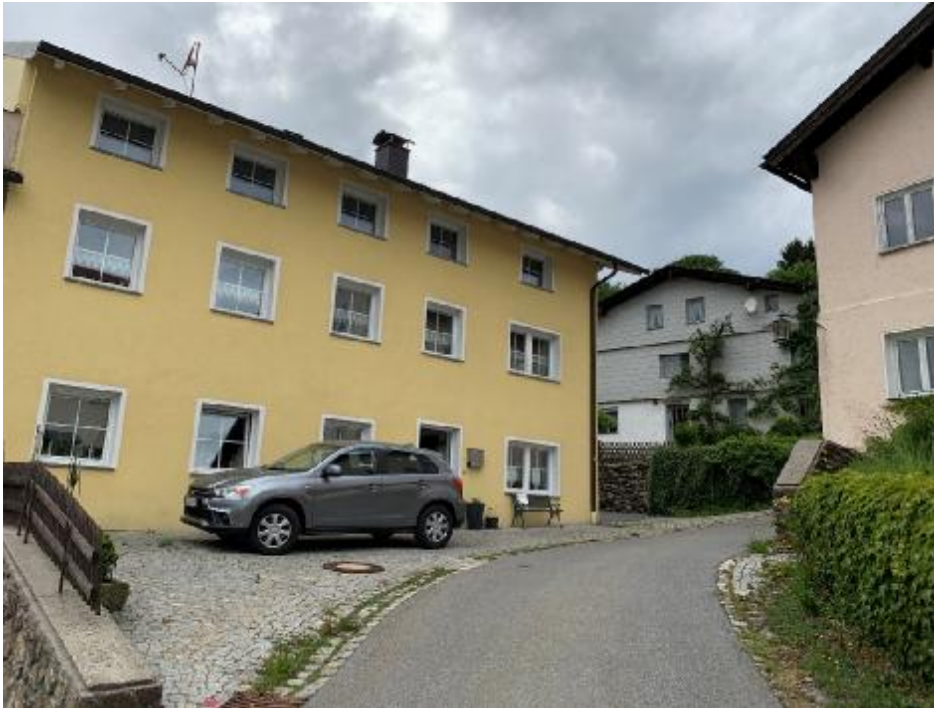
Abbildung 7: Bestandsgebäude westlich des Planungsgebietes, Foto Jocham+Kellhuber
